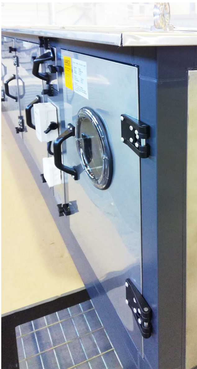
HSY hajunpoistoyksikkö, Helsinki Aktiivihiilisuodattimella varusteltu MEL (hst)
